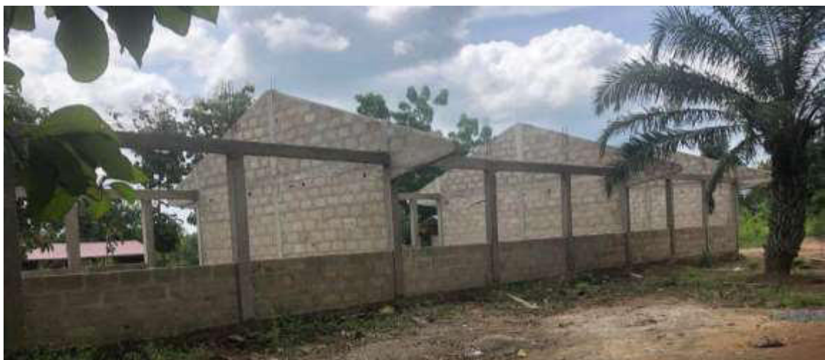
Avancement travaux 2ème bâtiment – le toit devrait être terminé pour fin mars
