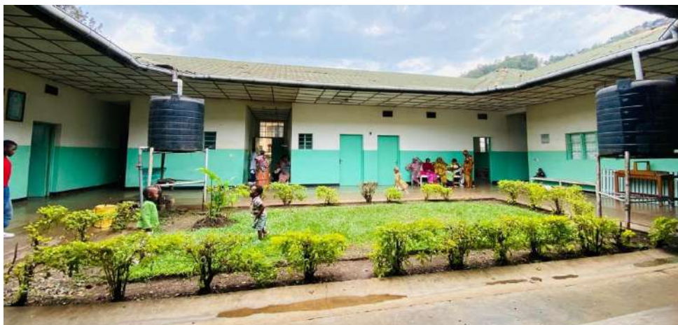
Cour intérieure où seront aménagés des modules ludiques pour développer l'activité physique
